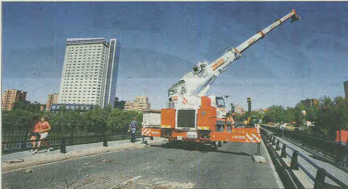
Última intervención de limpieza en el Puente Mayor, la semana pasada, para retirar troncos y maleza. / FOTOS: JONATHAN TAJES
