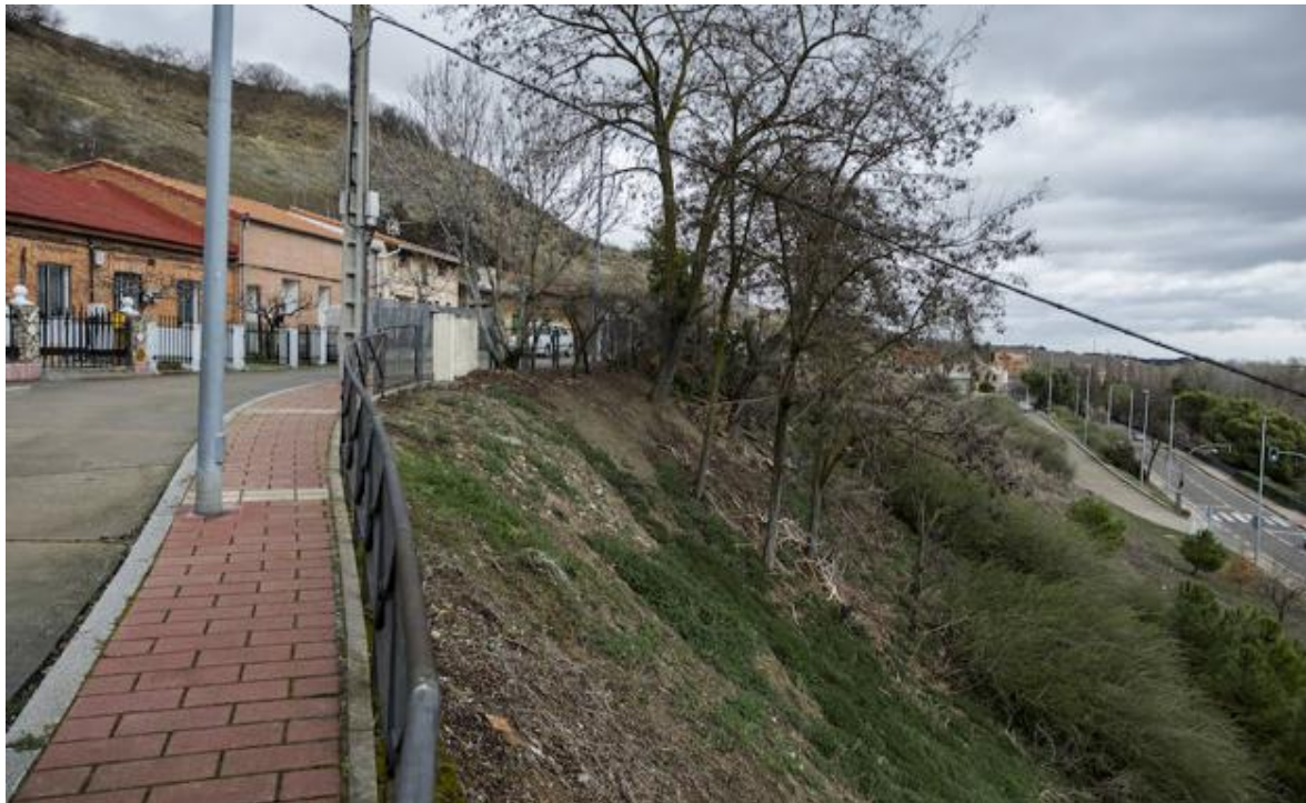
Ladera, paralela a la Carretera de Fuensaldaña, que se consolidará. / G. V.
